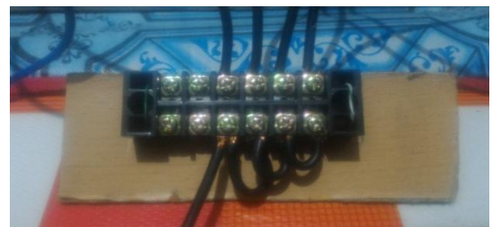
Gambar 12. Proses Pengkabelan Pada Blok Terminal
